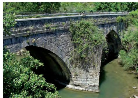
De origen románico, tiene tres arcos apuntados y dos tajamares triangulares de mampostería. En 1550 está documentado el cobro de canon por el paso de leña bajo sus vanos. Consta una reforma importante en 1652, con un coste de 410 ducados. En 1982 fue reemplazado por otro moderno para el paso de la carretera.
