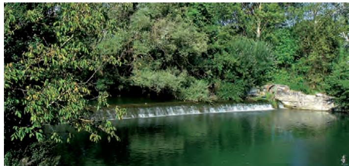
La presa de Zokoa, construida con sillares, derivaba agua para riego y para el molino de Olaz, más tarde convertido en central eléctrica. El conjunto presa-molino se remonta a tiempos medievales y está documentado desde el siglo XIII. El canal de abasto se salvaba en tiempos con puentecillos de madera.
